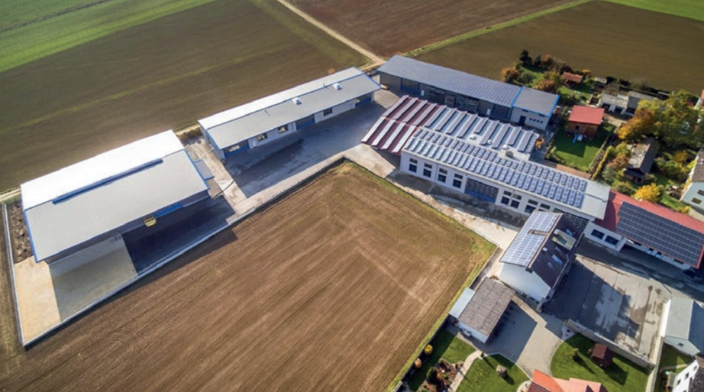
Photovoltaikanlagen auf den Dächern unserer Werkhallen tragen zur Eigenversorgung bei und decken rund 50 % des Produktionsenergiebedarfs.
